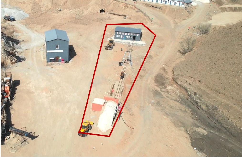
照片 1-6 斜井工业场地
