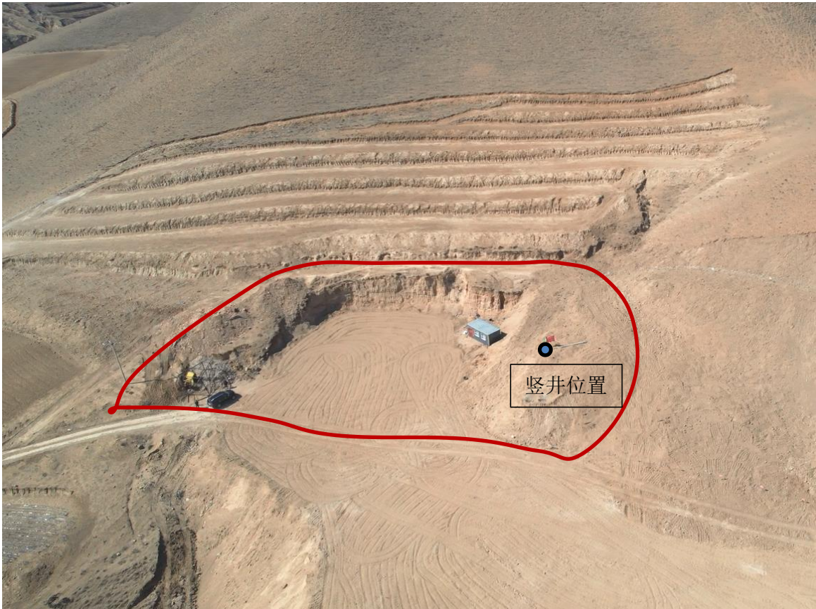
照片 1-4 竖井 3 工业场地
