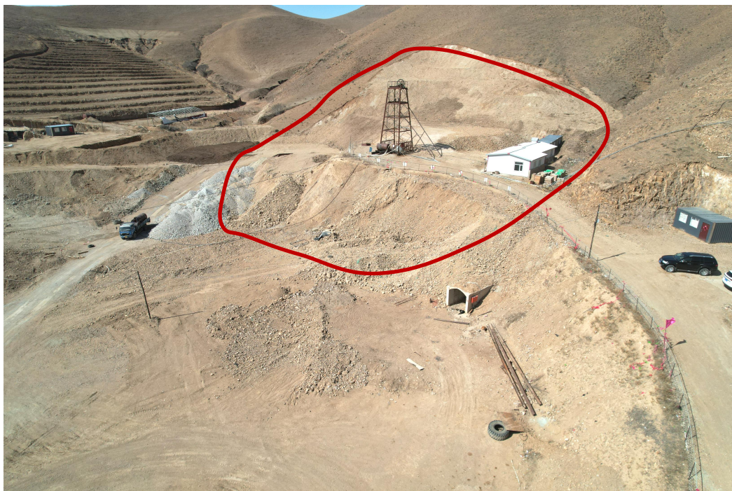
照片 1-3 竖井 2 工业场地
