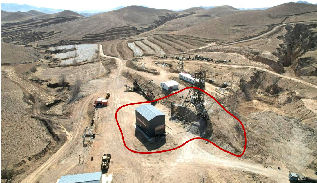
照片 1-2 竖井 1 工业场地
