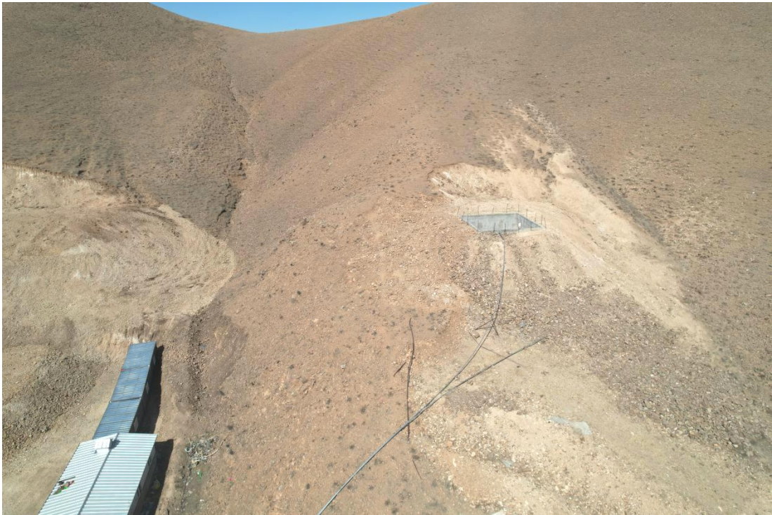
照片 1-15 高位水池
