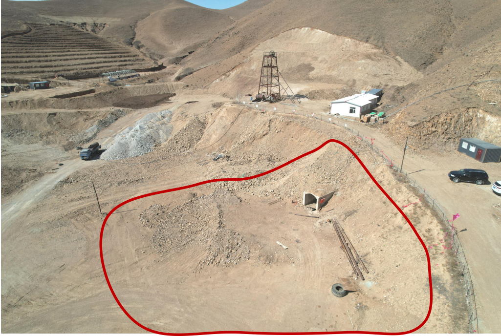
照片 1-5 平硐工业场地
