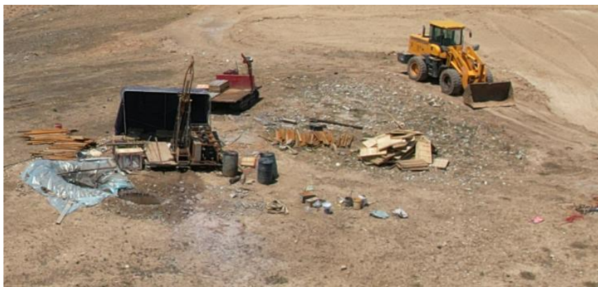
照片 1-9 钻机平台 2
