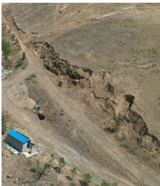
照片1-15 矿区道路
