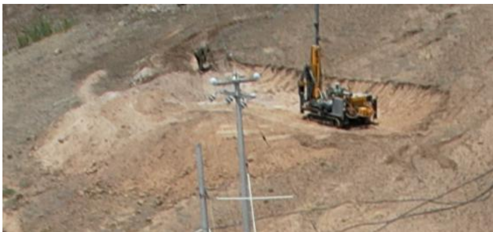
照片 1-8 钻机平台 1
