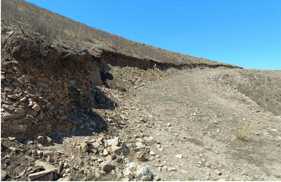
照片 1-1 矿区道路
