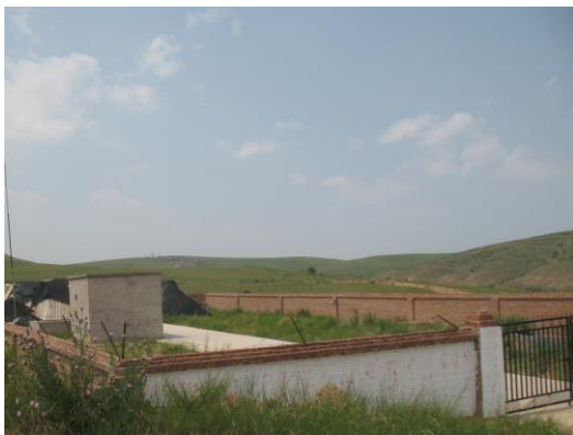
照片 3-18 雷管库和炸药库 1
