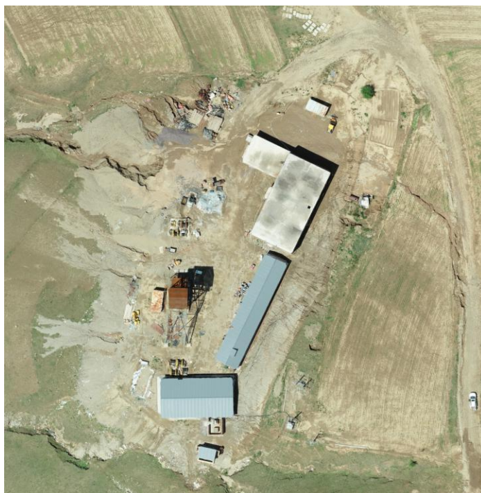
照片3-23 西矿区SJ5工业场地、SJ5废石堆及SJ5办公生活区
