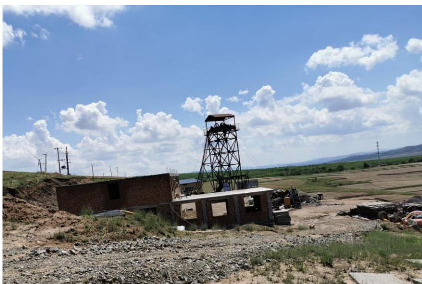
照片3-24 西矿区SJ5工业场地
