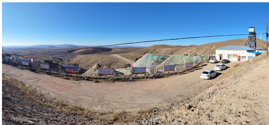
照片 4-5 竖井（SJ3）工业场地
