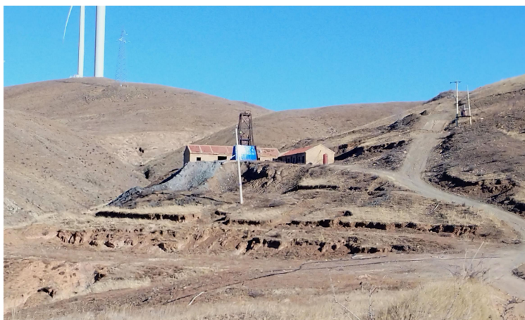
照片 4-1 竖井（SJ1）工业场地及废石场
