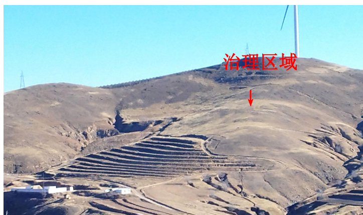
照片 2-1 前期探槽、剥土 1、表土存放场 1 治理后效果现状
