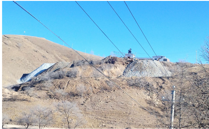
照片 4-7 竖井（SJ4）工业场地、废石场
