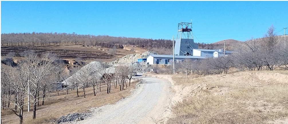
照片 4-8 竖井（SJ6）工业场地、废石场
