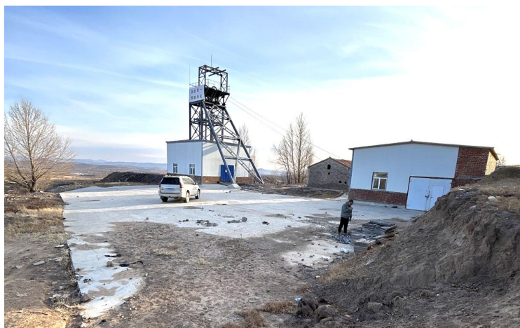
照片 4-10 竖井（SJ5）工业场地
