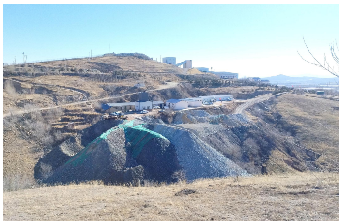
照片 4-4 竖井 (SJ2) 工业场地、废石场
