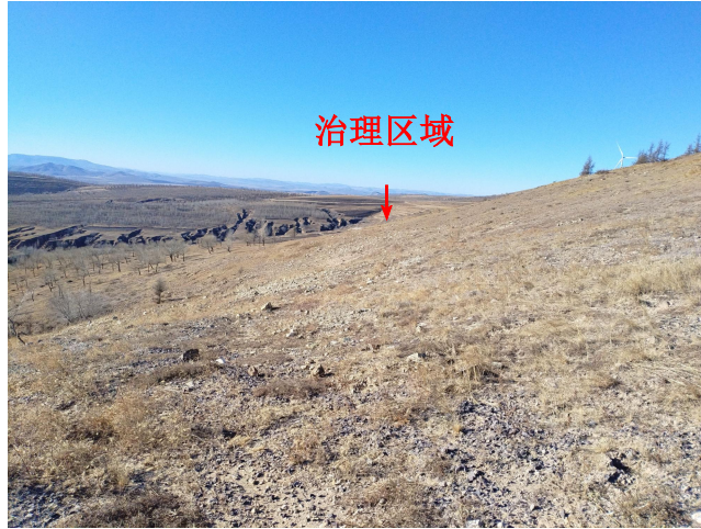
照片 2-4 前期原二采区钻机平台治理后效果现状
