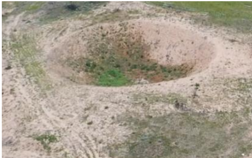
原拟建 1#高位水池现状
