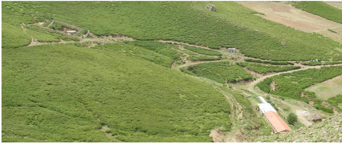
照片 4-5 矿区道路
