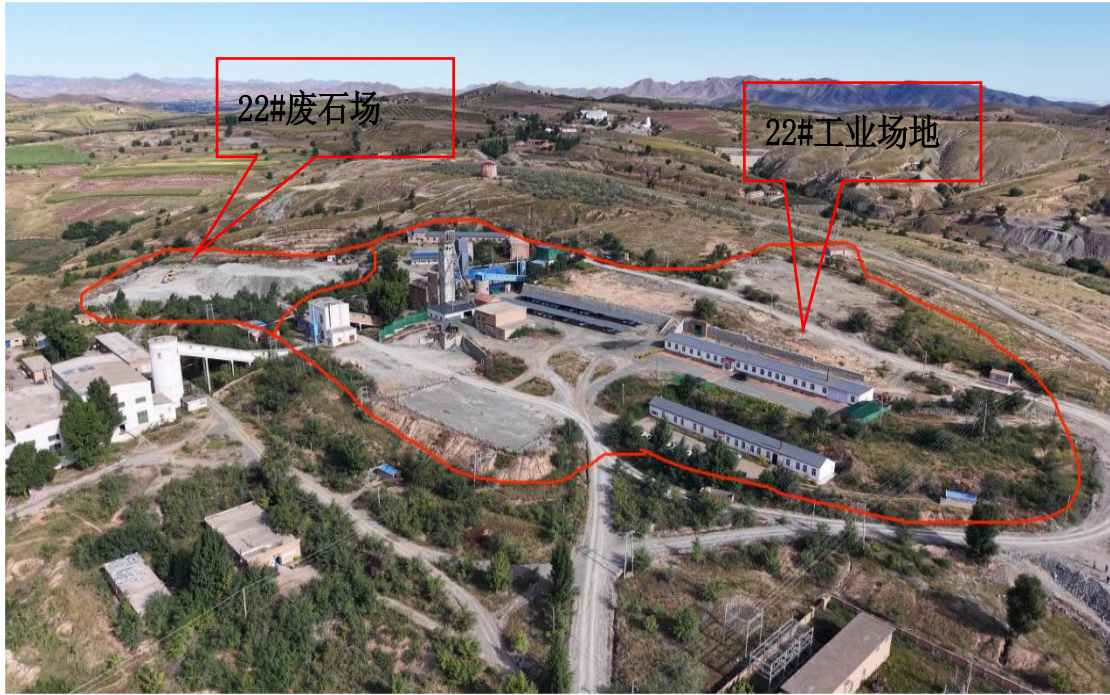
照片 3-42 22#工业场地全景
