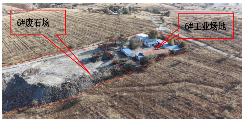
照片 3-11 6#工业场地全景
