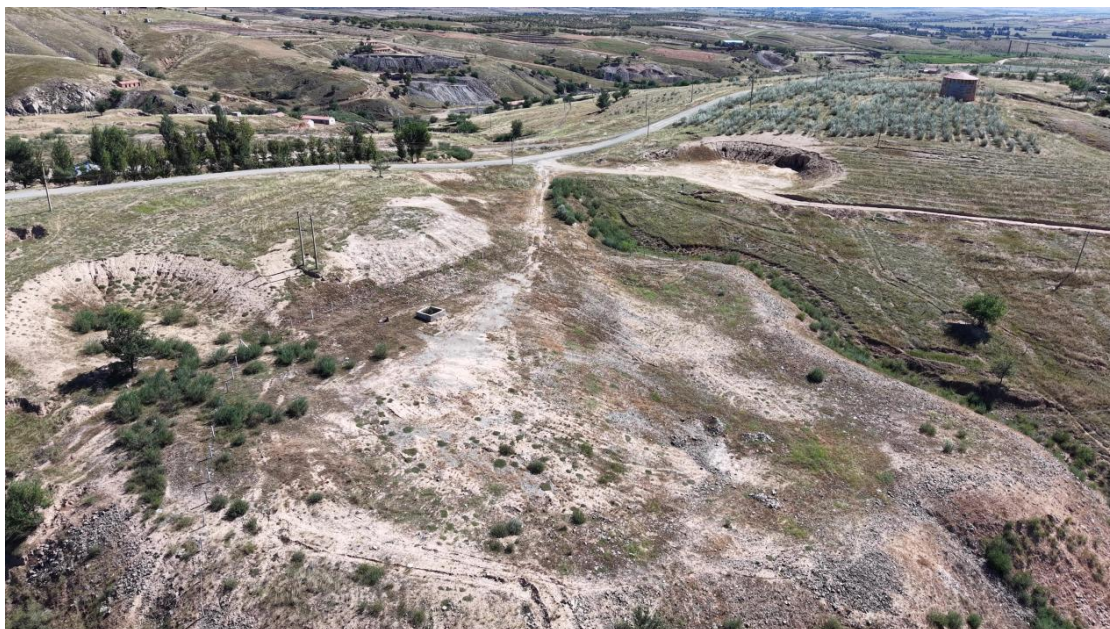
照片 3-54 29#工业场地全景
