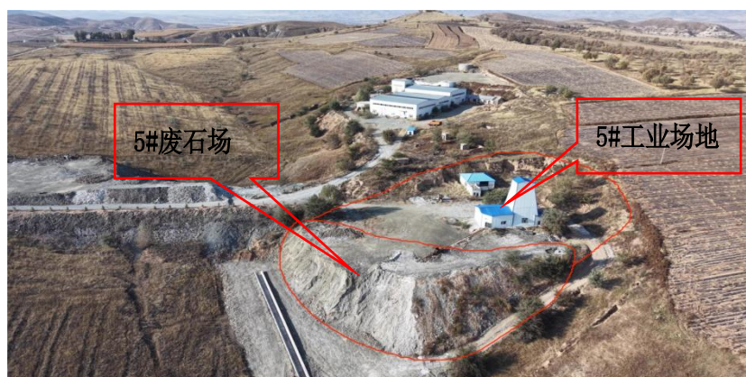
照片 3-9 5#工业场地全景
