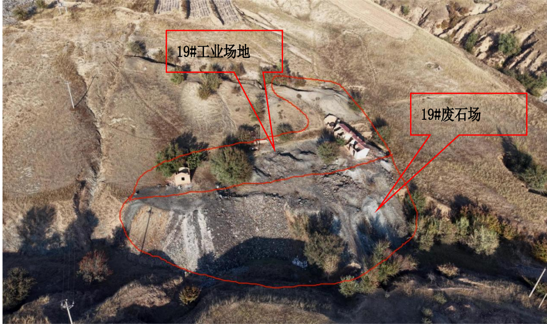
照片 3-36 19#工业场地全景
