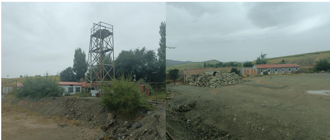
照片 3-17 8#工业场地西南侧近景
