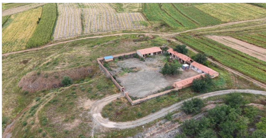
照片 3-13 7#工业场地全景
