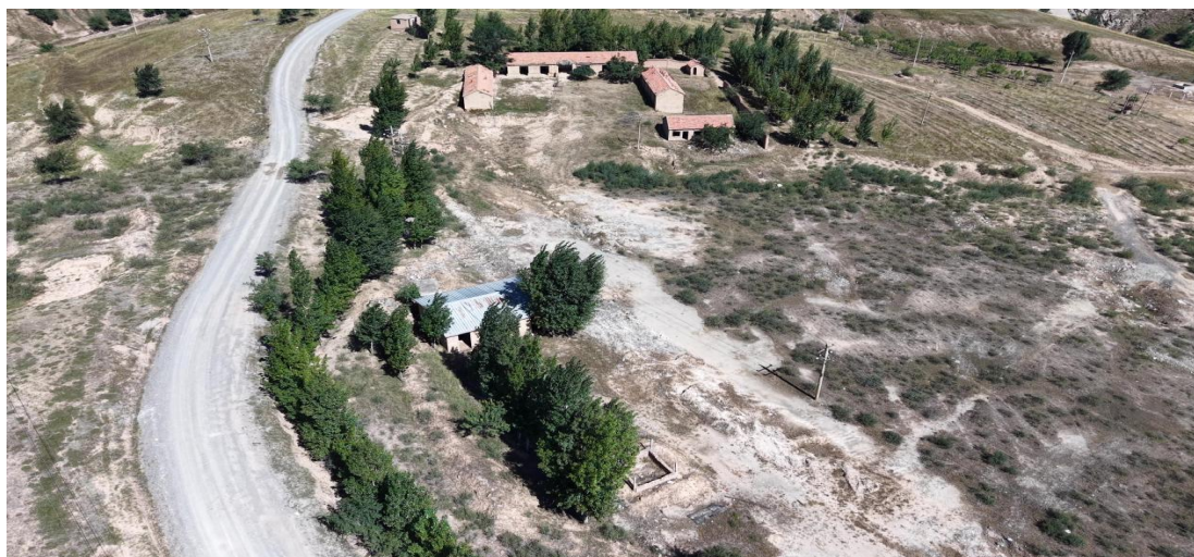
照片 3-56 30#工业场地全景
