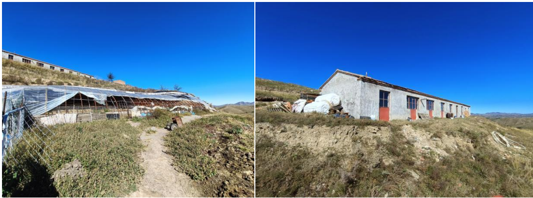
照片 3-3 1#工业场地暖棚、仓库近景
