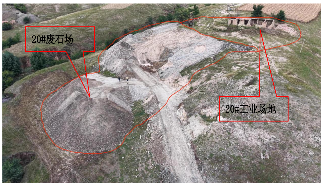
照片 3-38 20#工业场地全景
