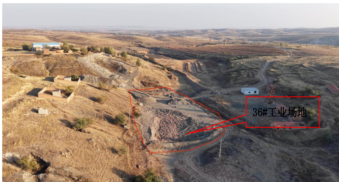
照片 3-65 36#工业场地全景
