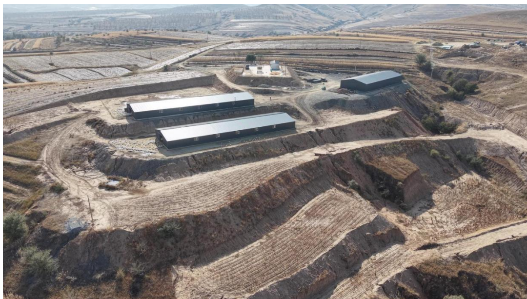
照片 3-6 3#工业场地全景
