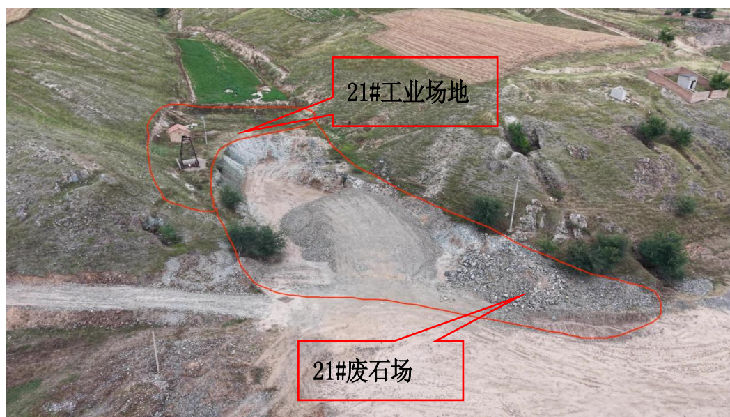
照片 3-40 21#工业场地全景
