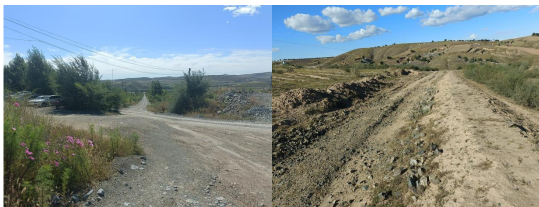
照片 3-117 矿区道路
