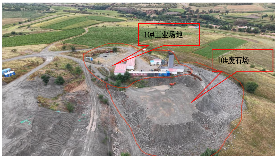
照片 3-20 10#工业场地全景
