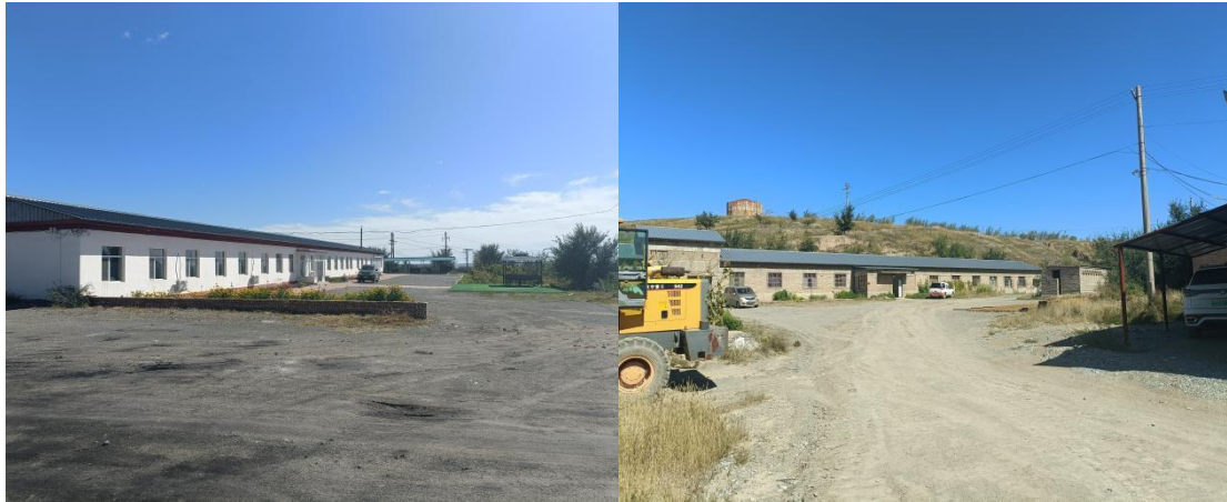
照片 3-45 22#工业场地办公室、库房
