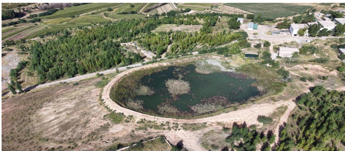
照片 3-98 蓄水池全景
