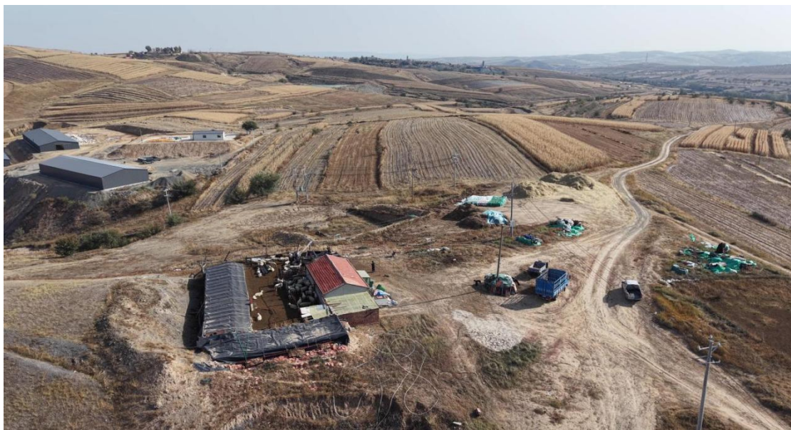
照片 3-4 2#工业场地全景
