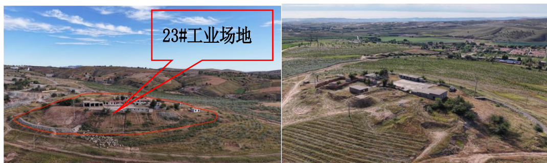
照片 3-47 23#工业场地全景
