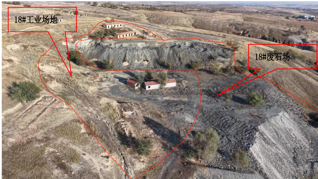
照片 3-34 18#工业场地全景
