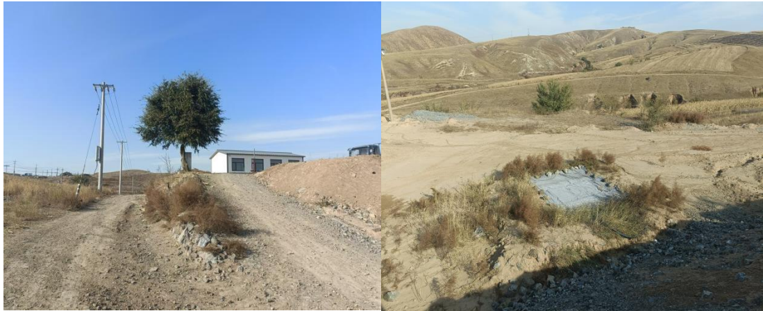
照片 3-8 3#工业场地宿舍及竖井
