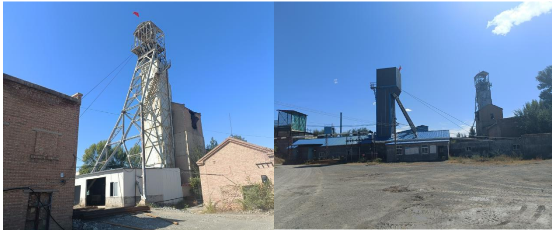
照片 3-43 22#工业场地主井、副井近照
