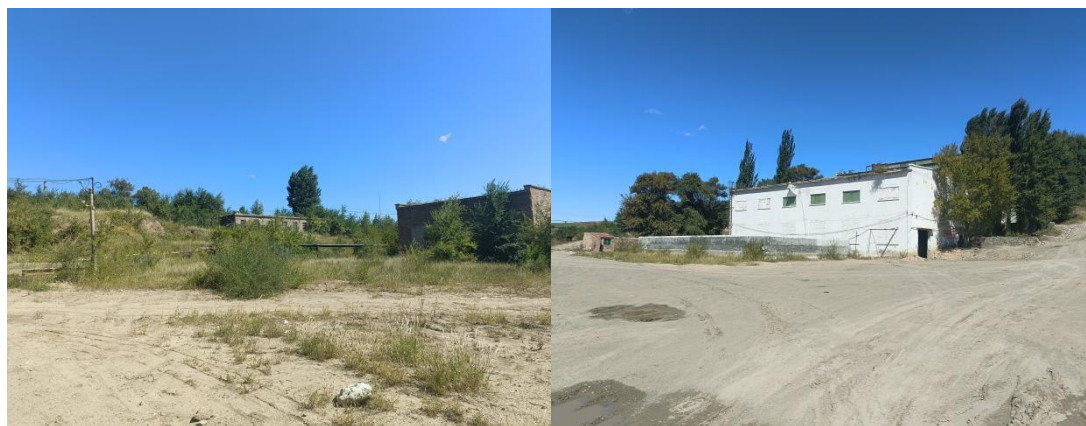
照片 3-94 仓库、厂房
