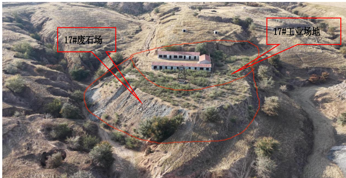
照片 3-32 17#工业场地全景
