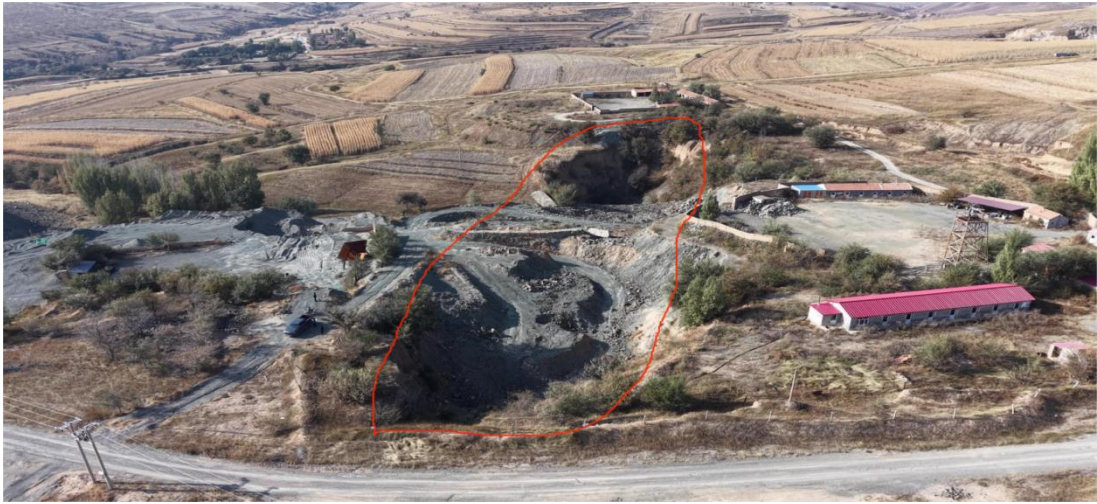
照片 3-115 塌陷坑全景
