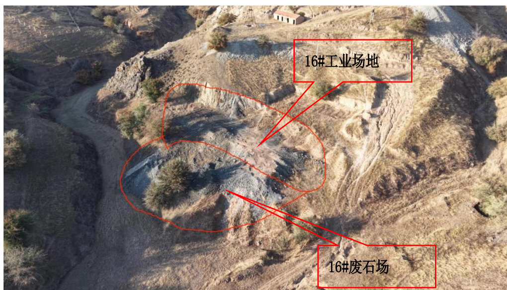
照片 3-30 16#工业场地全景
