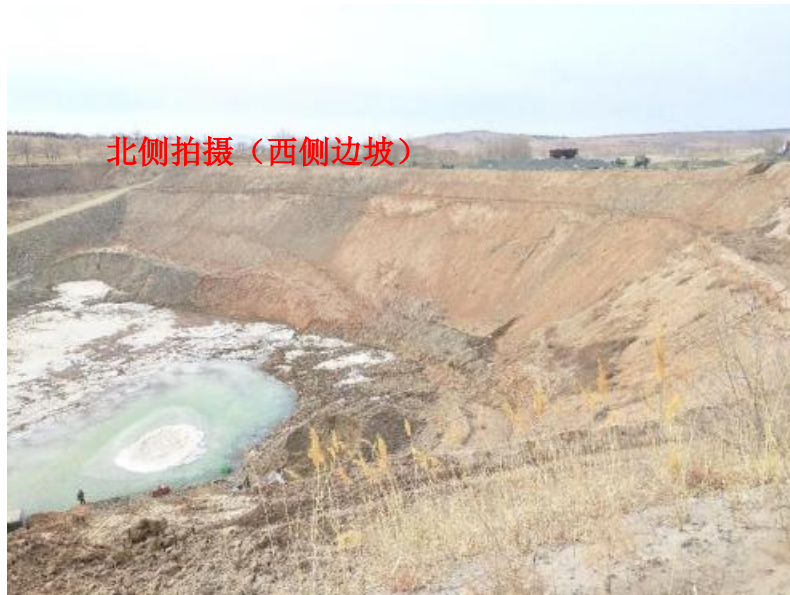
照片 4-1 露天采坑
