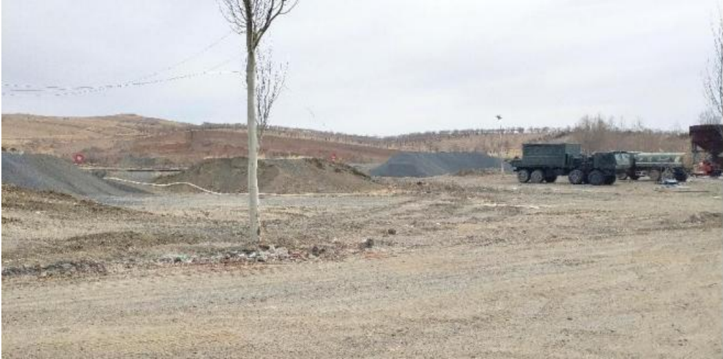
照片 4-13 材料堆积场地
