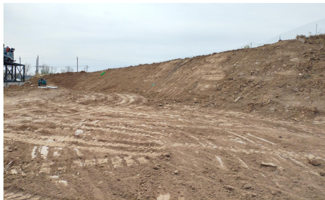
照片 2-2 前期炸药库（现改建为库房）、选厂边坡整形治理后效果现状
