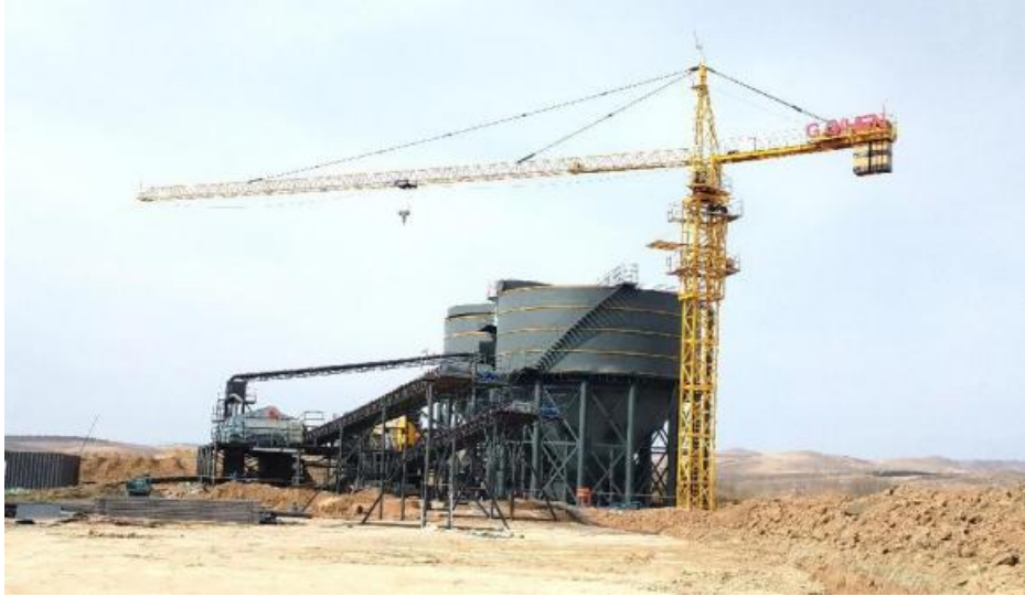
照片4-8 高位水池
