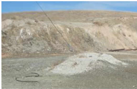
照片 4-8 办公生活区 (拆除场地)
