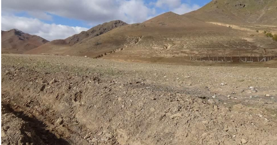
照片1-3 前期治理区（矿石堆放场北侧）
