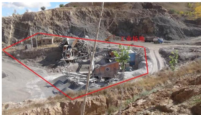
照片 3-2 工业场地全景
