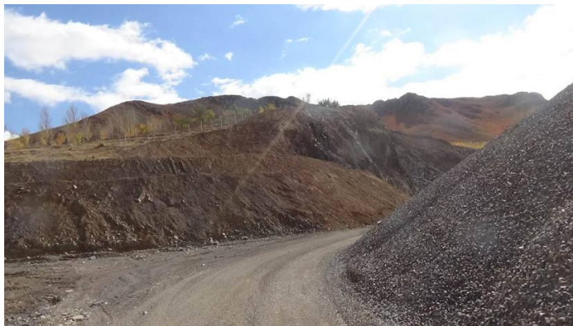
照片3-6 矿区道路
