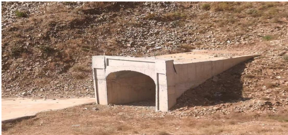
照片2-8 平硐坑口
