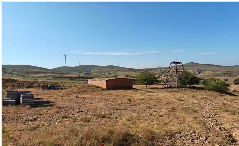
照片2-2 工业场地1全景
