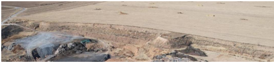
照片 1-4 原露天采场西侧治理效果照片
